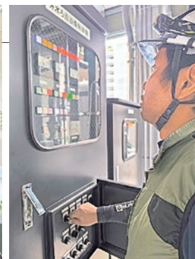
水処理装置設置作業の様子
