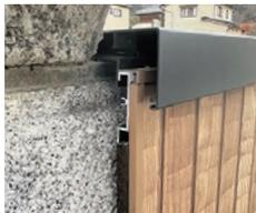
⬆️ 既存の塀(左側ブロック塀)に新しく壁材(右側部分)を被せて取り付け
